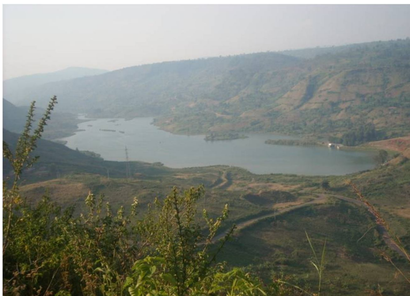
Figure 1. Photo du réservoir du barrage Ruzizi II à Mumosho (Baie de Chiandja) qui constitue à ce jour un petit lac de retenue.
